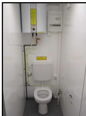
Toiletrum m. kværn toilet og udsugning.
